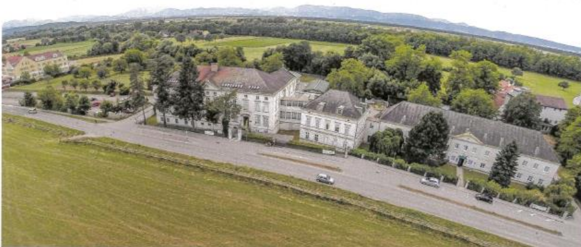
In den vergangenen Sommerferien wurde in der Schule in Frohsdorf intensiv renoviert, wie zum Beispiel im Schulgarten oder in den Klassen.
